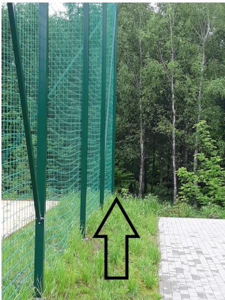
Miejsce montażu pierwszej lampy - w rogu, poza ogrodzeniem
